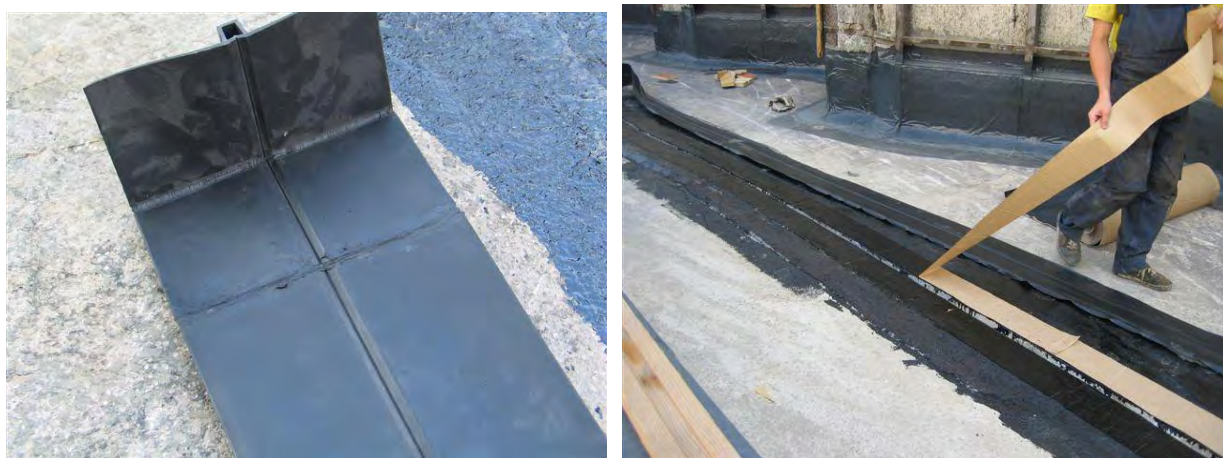
Slika 18, 19: Serviseal Type B dilatacijski vložek z tipskim kosom vertikale in prikaz vgradnje dvostransko lepljivega traku Bitustick 15 cm
