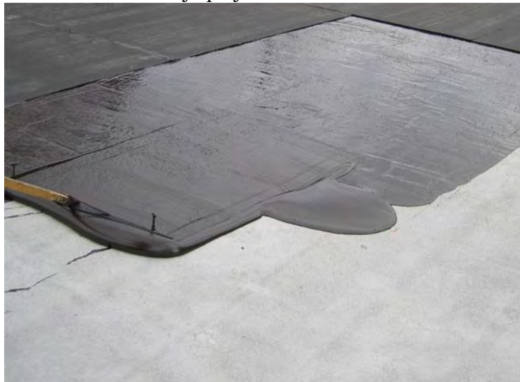
Slika 4: Enakomerno razporejanje Servidek mase
