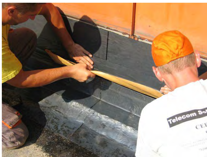
Slika 14, 15: Vgradnja Bituthene membrane na pripravljeno površino in utrjevanje s valjčkanjem
