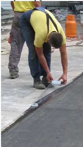
Slika 8, 9: Zaščita dnevnih stikov s polietilensko folijo
