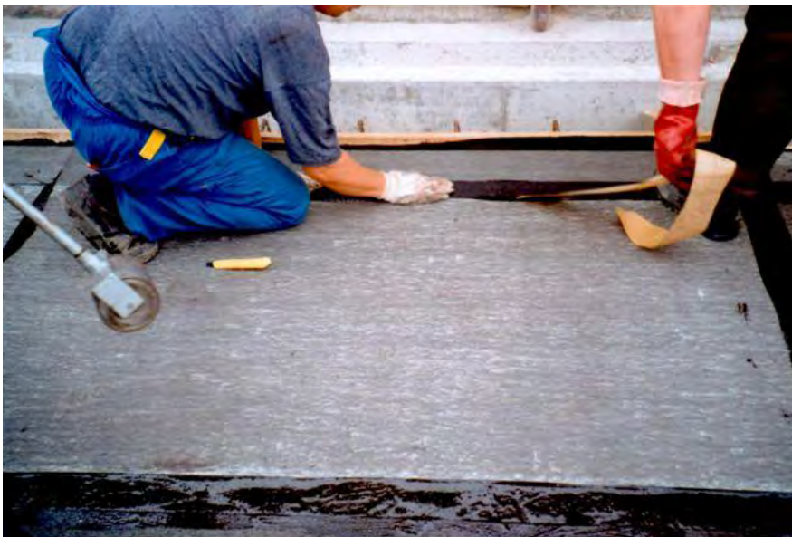
Slika 10: Bandažiranje spojev plošč z Armourtape trakom.
