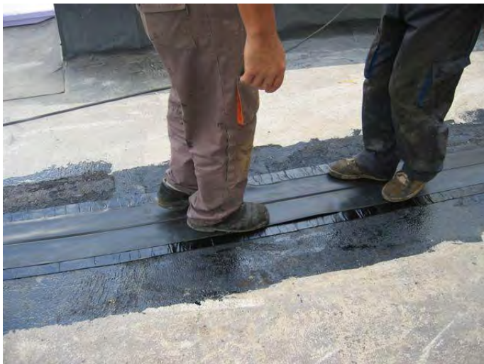
Slika 20, 21: Vgradnja dilatacijskega vložka Serviseal Type B in preko njega Bituthene membrana v širini 50 cm.
