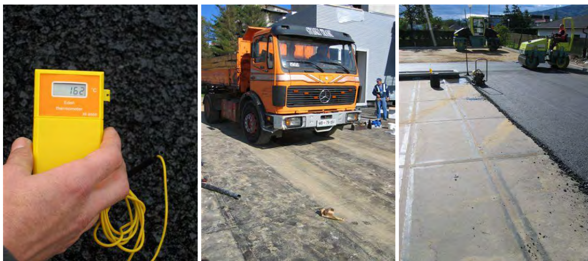
Slika 28: Temperatura asfalta pred valjanjem je 162 °C.
