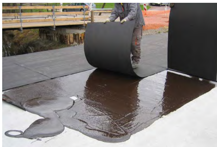
Sliki 5 in 6: Polaganje Servipak zaščitnih plošč v sveži Servidek
