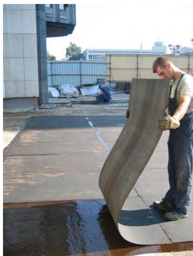
Sliki 5 in 6: Polaganje Servipak zaščitnih plošč v sveži Servidek
