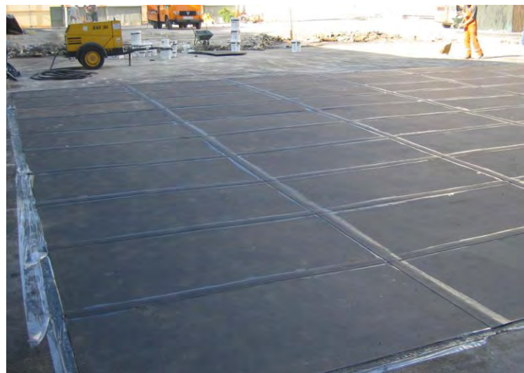
Slika 8, 9: Zaščita dnevnih stikov s polietilensko folijo
