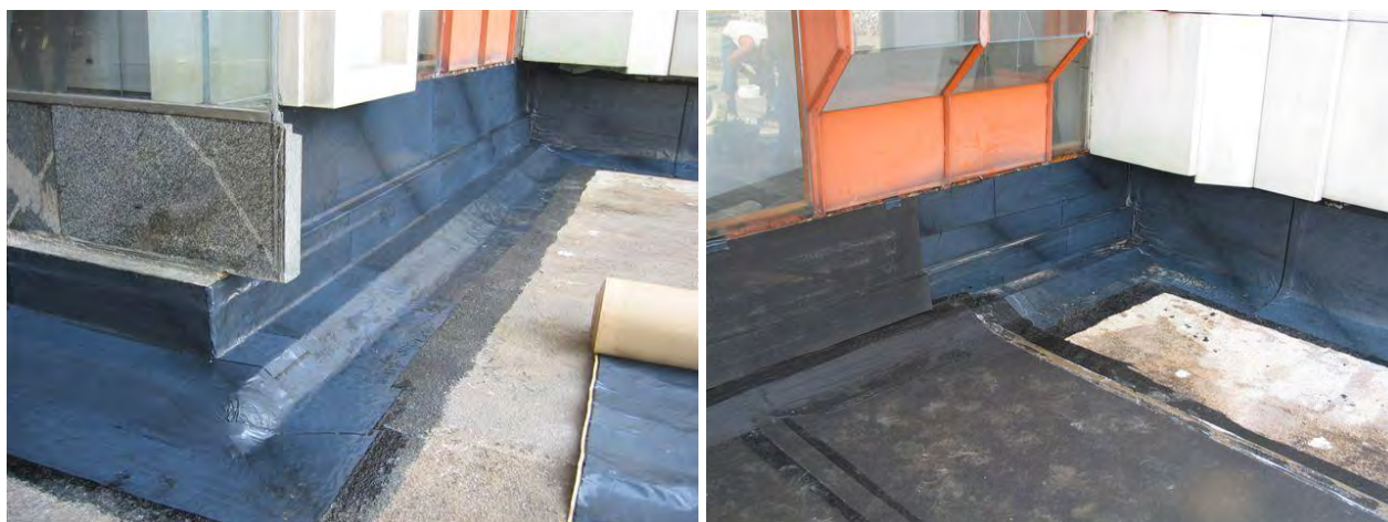
Slika 16, 17: Pripravljena vertikala za nadaljevanje s horizontalno hidroizolacijo in že vgrajena horizontalna hidroizolacija Servidek z zaščito Servipak ploščami.
